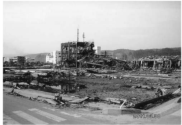
津波により被災した南三陸町防災対策庁舎と公立志津川病院（奥の白い建物） 行政機関、医療機関の機能喪失
