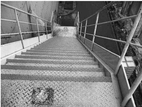
図3 事例2 (46歳男性, 工場勤務, 網膜色素変性症) 工場の建屋の階段 階段の縁に黄色のラインを付けることで, 段差の視認性を向上させた。
