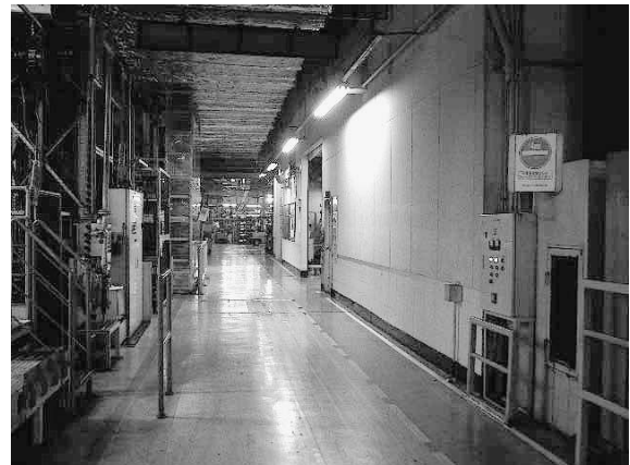
図4b 事例2 (46歳男性, 工場勤務, 網膜色素変性症) 工場内の照度の確保 (対策後)
